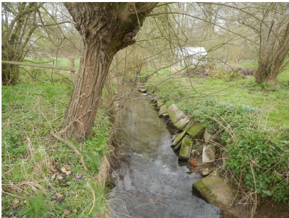
Abb. 6: Uferverbau 2012 gegen die Fließrichtung
